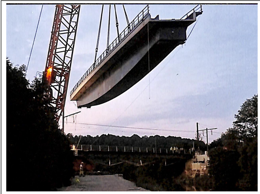
Le nouveau pont survole la Sambre
